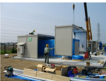
4. ドッキング作業中
