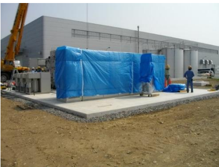
1. 基礎上に機器を設置
