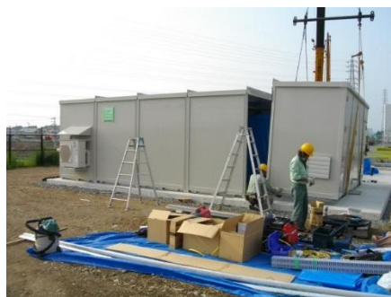
5. 最後の分割ユニットを据付
