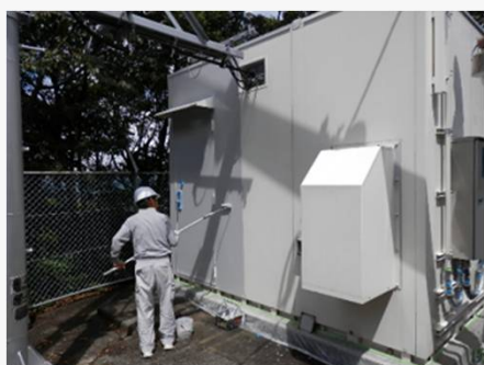
▼シェルター全面改修
