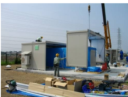
4. ドッキング作業中
