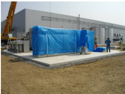
1. 基礎上に機器を設置
