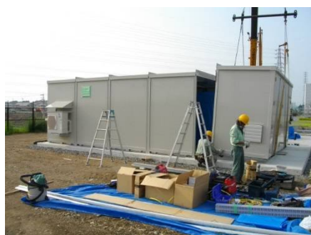
5. 最後の分割ユニットを据付
