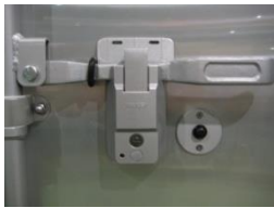
電気錠 解錠スイッチ
