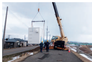
17 設置工事 工場組立完成型
