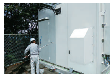
18 シェルター全面改修
