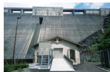
12 水力発電所用（電気室）
