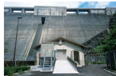
12 水力発電所用（電気室）
