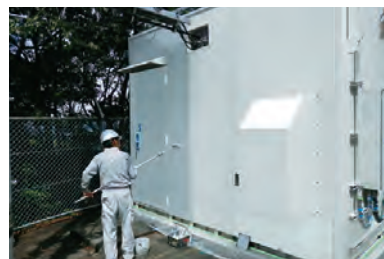
17 シェルター全面改修
